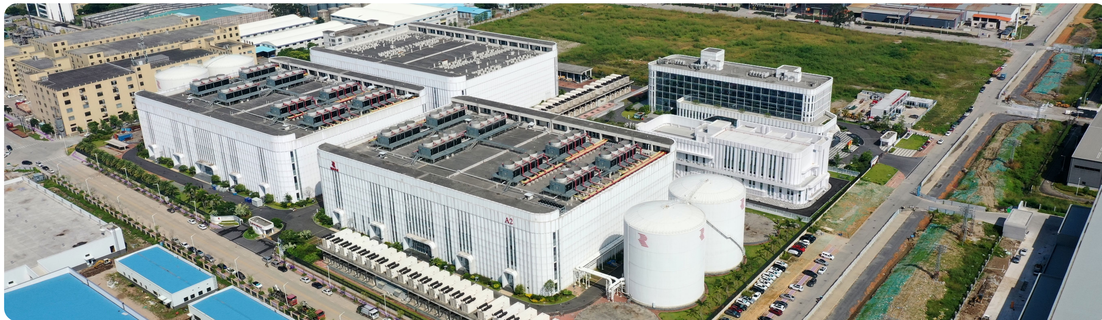
▲ Foshan Runze Data Center
